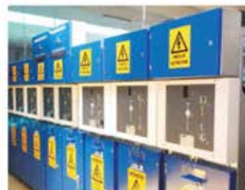
Celule de medie tensiune gama MOD6
